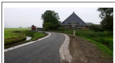
Voorbeeld van wegverbreding met bermbeton
